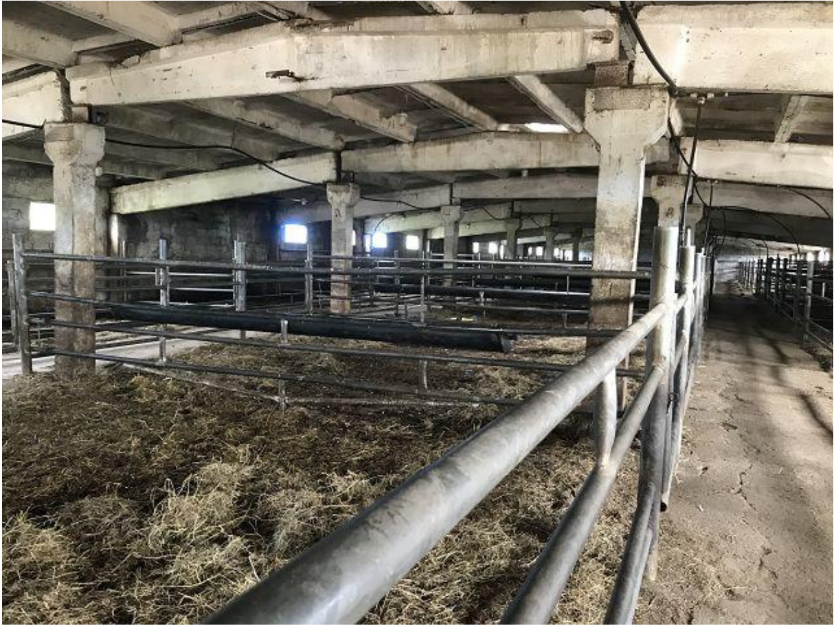
Bild 2: Innenansicht des Stalls – Station Sosnovka
