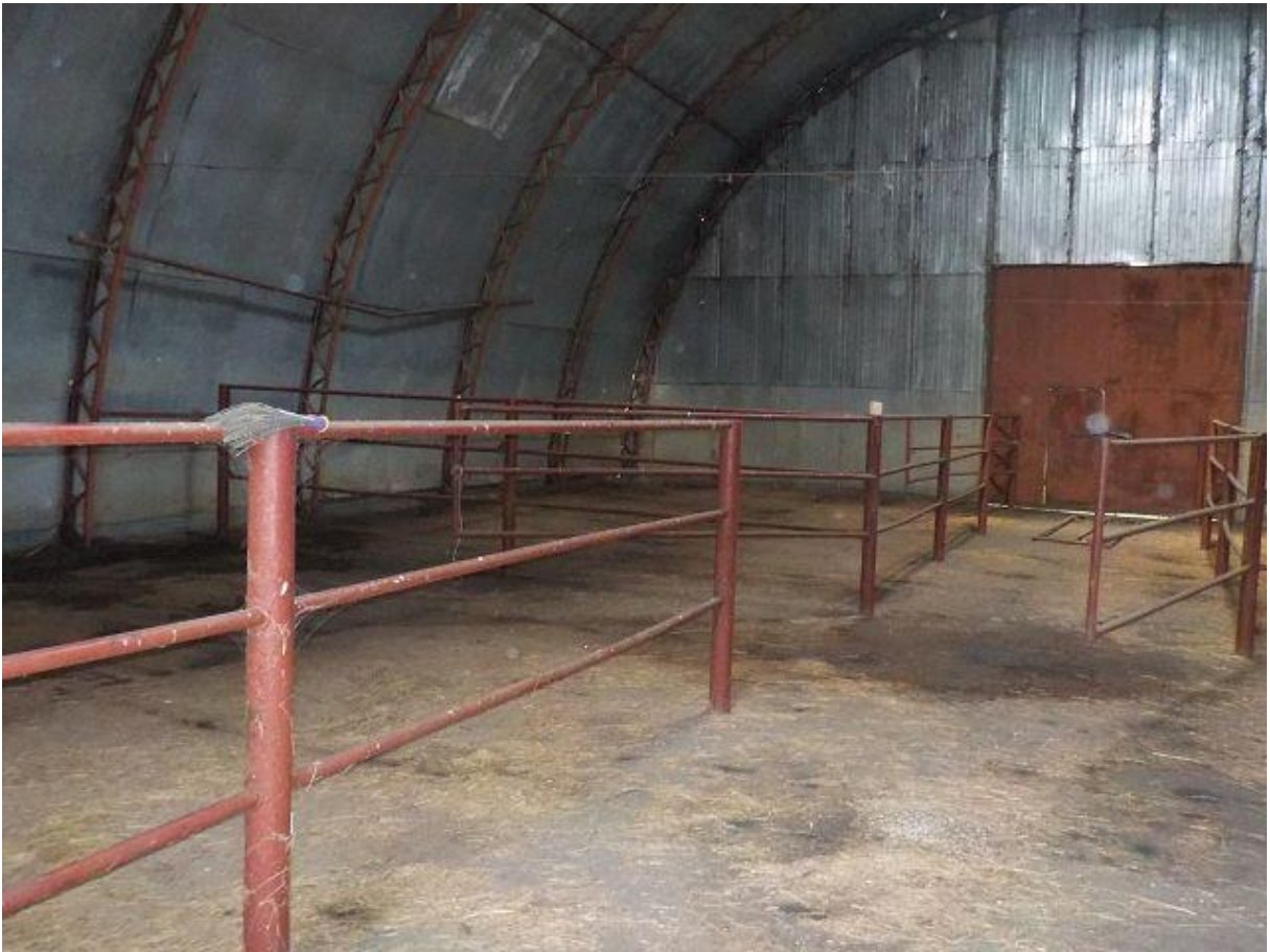
Bild 6: Innenansicht der Rundhalle – Station Gagarin
