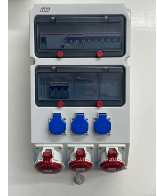
Beispiel: Stromanschluß Arbeitsbereich
